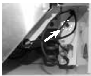
Återställningsknapp för övertemperaturskyddet på eftervärmens luftvärmare (endast modeller med elektrisk luftvärmare)
